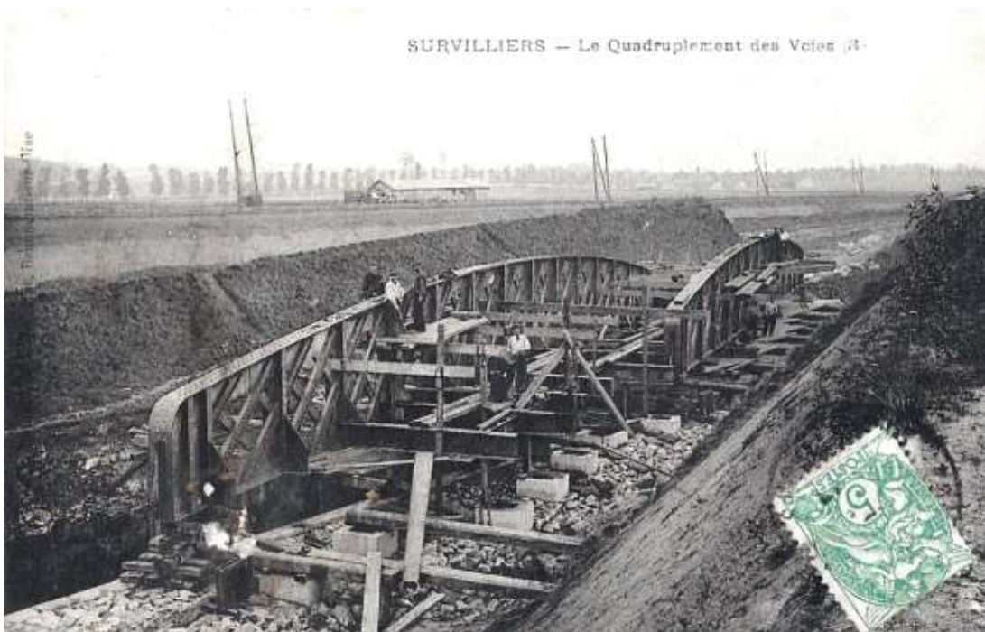
La préparation du saut-de-mouton de Survilliers qui va permettre de réaliser le quadruplement de voies entre Survilliers et Orry-la-Ville – Coye-la-Forêt)
