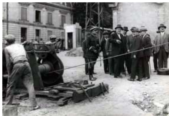
M. Javary, directeur du Chemin de fer du Nord assiste, à la mise en place du Pont sur l'Oise sous les voies ferrées de Paris à Pontoise.
