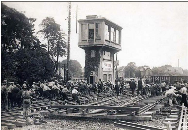
Pontoise : travaux devant le poste d'aiguillage lors du changement des aiguilles et appareils de voies
