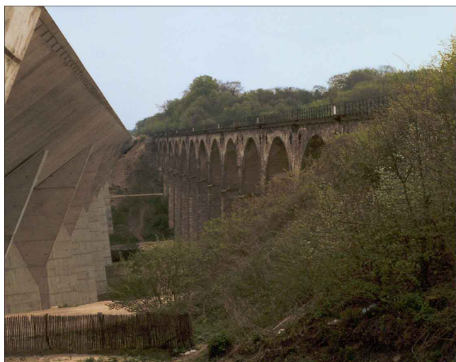
Le nouveau viaduc construit depuis peu et l'ancien viaduc non encore démolit
