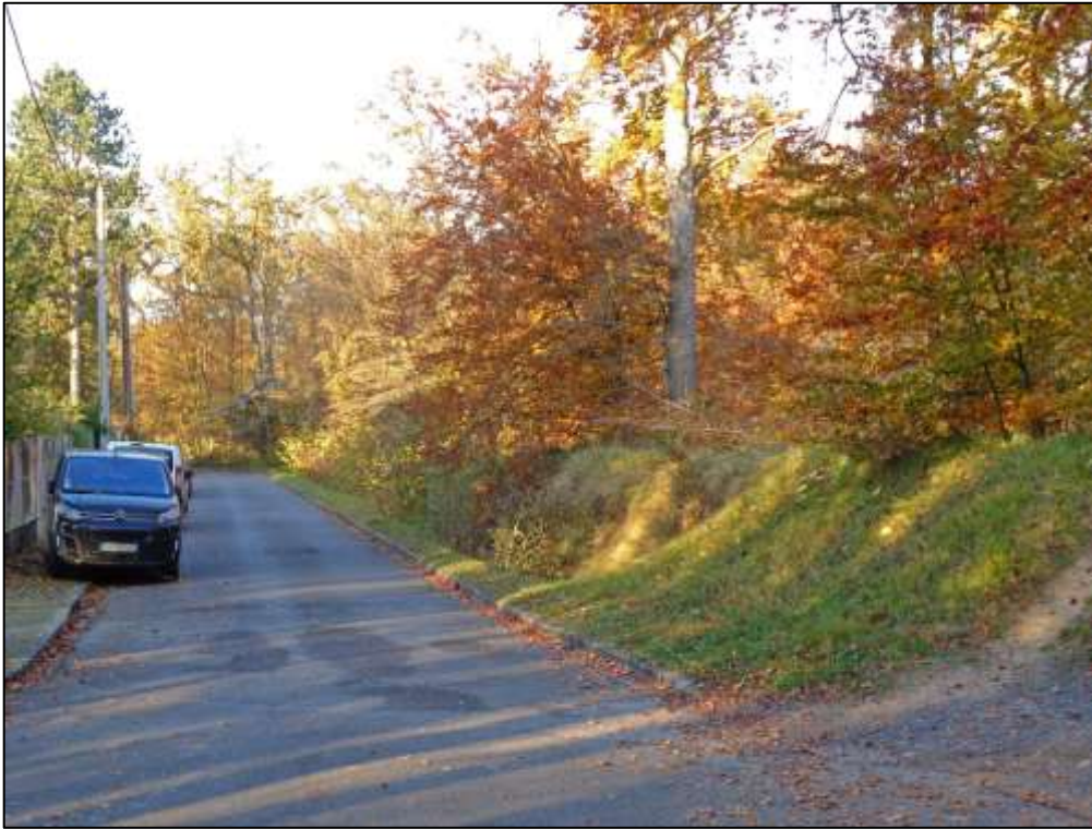
Préconisation : araser les bordures de trottoir afin que l'eau puisse s'évacuer sur le côté, vers la forêt dans la noue – Ici haut de la côte de Bellevue.
